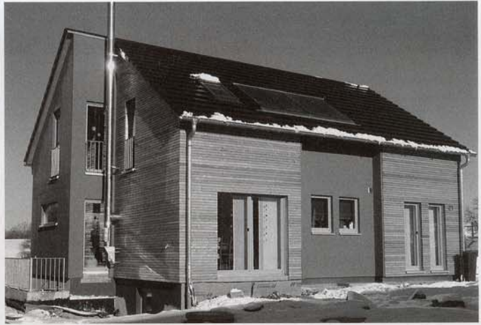
Solaranlage zur Energiegewinnung passt sich farblich an Ziegeln des Satteldachs an
